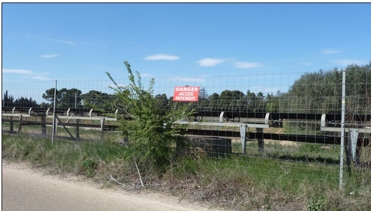
Figure 2: exemple de clôture et panneau avertisseur (bande transporteuse actuelle)
